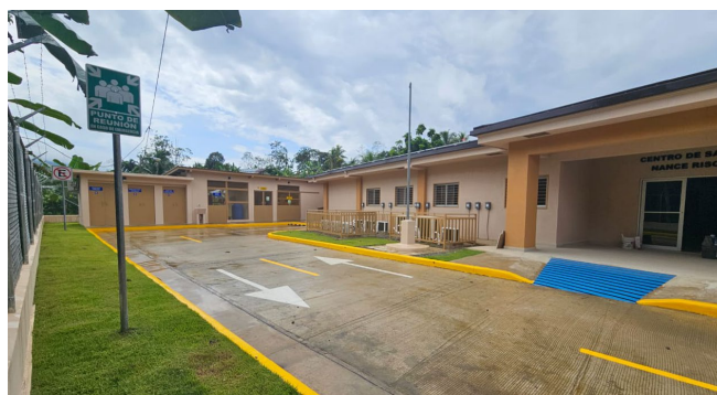
Nuevas infraestructuras de salud de Nance Risco y las Delicias.
