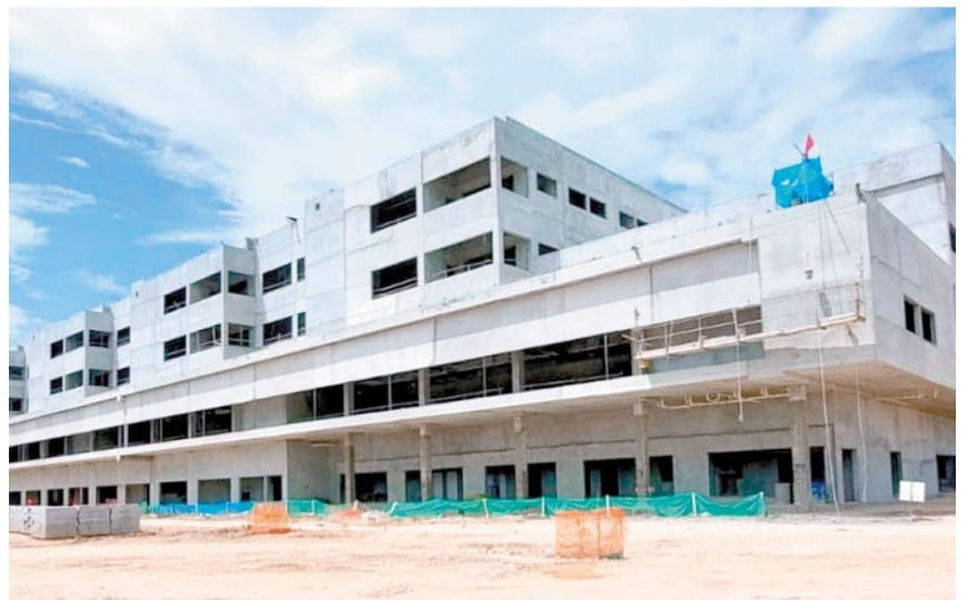
Nuevo Hospital, Aquilino Tejeira, Coclé
