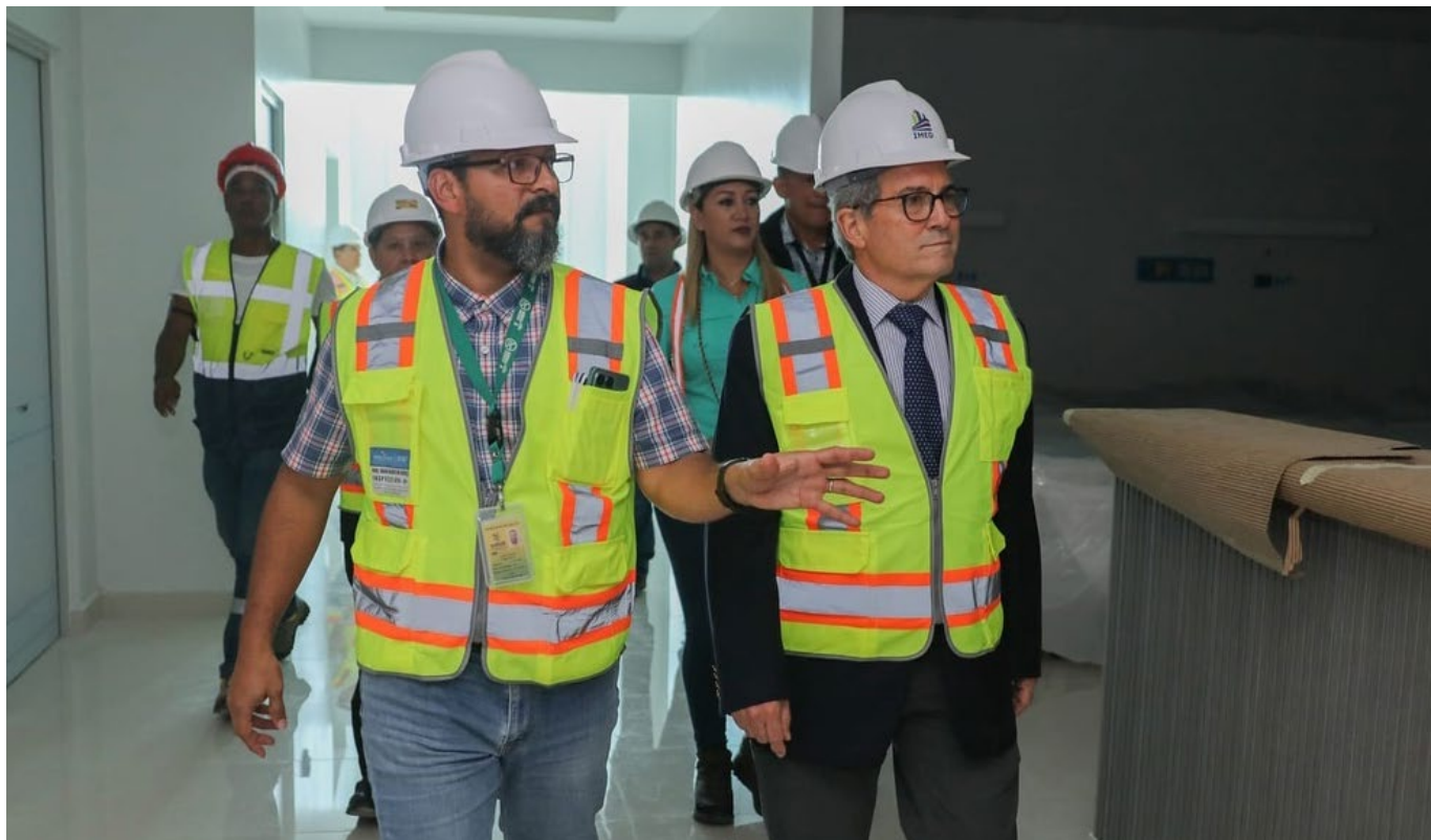
Para dar seguimiento a las obras en ejecución, el Ministro de Salud, Dr. Fernando Boyd Galindo acompañado del Viceministro Dr. Manuel Zambrano, realizó un recorrido en el nuevo Hospital Manuel Amador Guerrero de Colón.
