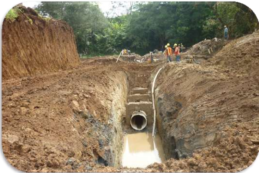
Instalación de tuberías Rib Steel de 36' de diámetro y construcción de bloque protector en el área de Villa María, El Progreso.
