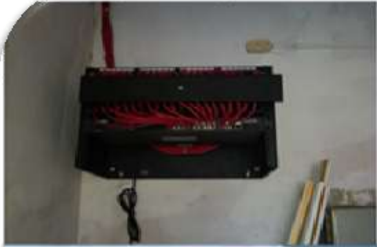
Instalación de redes y switch de 24 puertos
