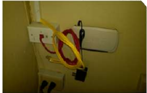
Instalación de switch de 8 puertos
