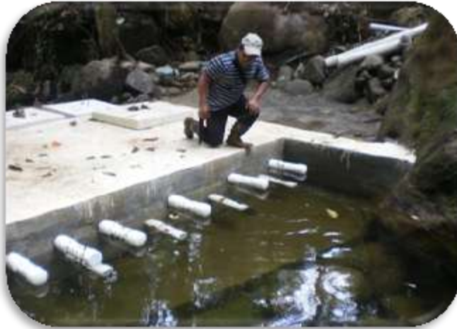
CONSTRUCCIÓN DE 13 ACUEDUCTOS, MARIPOSA, ALTO CASTILLO, GUAYABITO, CERRO BANCO, BOCA REMEDIO, CHUBE, BIJAO
